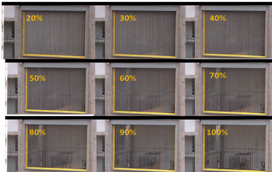
Fig. 5. Secuencia de fotografías mostrando diferentes porcentajes de apertura de atenuador.
