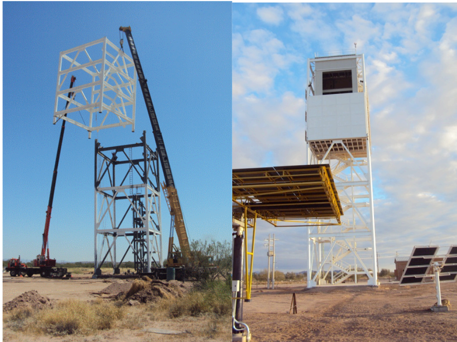
Figura 3. Proceso de construcción de la torre del CPH.
