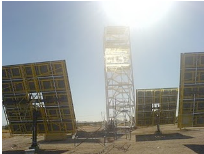
Figura 11. Pruebas de control en el CPH con tres helióstatos UNAM-CC-H36.
