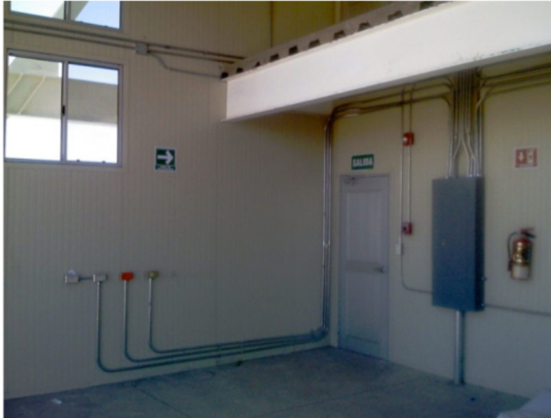
Figura 5. Cabina de experimentación en lo alto de la torre.
