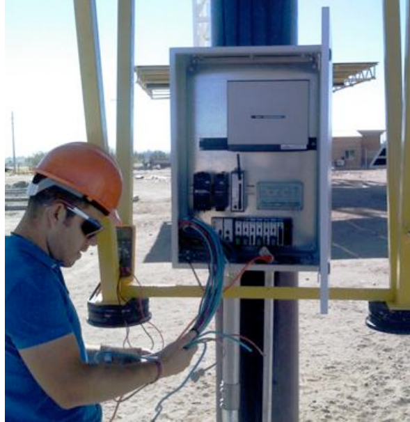
Figura 11. Instalación de gabinete de control en un helióstato.
