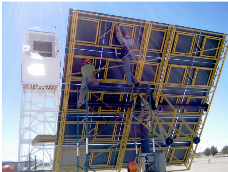
Figura 15. Prueba de observación de la mancha reflejada para un helióstato en proceso de canteo.
