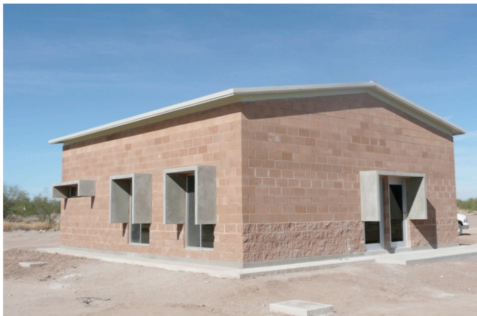
Figura 4. Edificio del cuarto de control del CPH.
