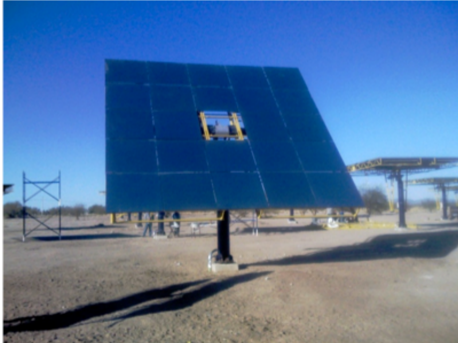
Figura 9. Helióstatos de 36 m 2 UNAM-CC-H36.
